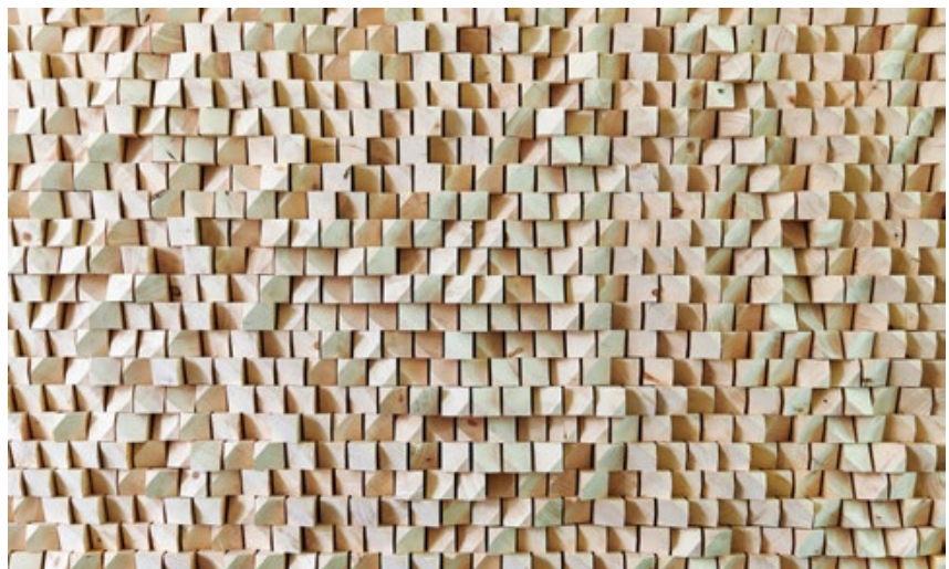
Die Akustikwand aus 1500 identischen Holzelementen wurde mit einer digitalen Planungsmethode entwickelt, und für den Bau der komplexen Muster kam ein neuartiges Montageverfahren mit Augmented Reality zum Einsatz. Architektur und Parametrisierung: Gramazio Kohler Research.
